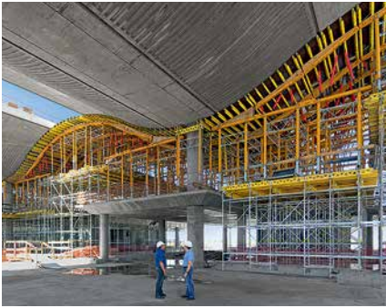
Системные элементы VARIOKIT и MULTIPROP создали экономическую основу для формообразующих опалубочных столов.
