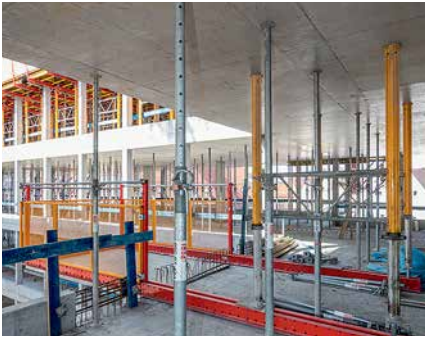
Направляющие подъемы выносных площадок RCS MP между двумя плитами перекрытий выполнены при помощи стоек MULTIPROP.
