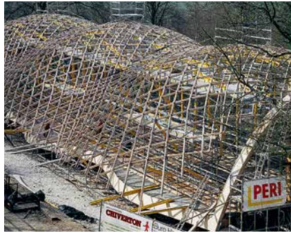
Стойки MULTIPROP служили основой для конструкций и обеспечивали изогнутую форму сетчатой оболочки.
