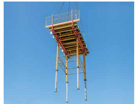
В столах VARIODECK стойки MULTIPROP фиксируются в нужном положении при помощи рам MRK.
