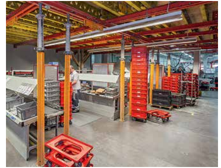
Несущая конструкция из стоек MULTIPROP и элементов системы VARIOKIT.
