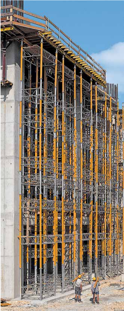
Башни MULTIPROP высотой 20 м для установки опалубки консольной плиты перекрытия.
