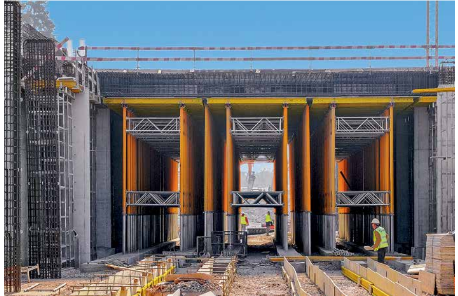
Башни MULTIPROP являются экономически эффективной альтернативой несущим лесам, особенно при большой высоте перекрытия.
